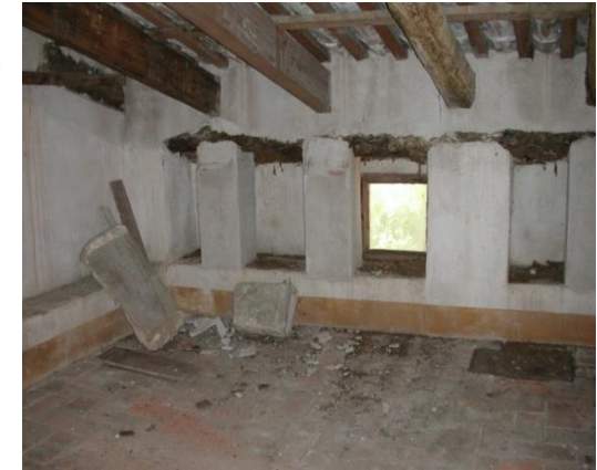
Solució Reparación Cubierta
