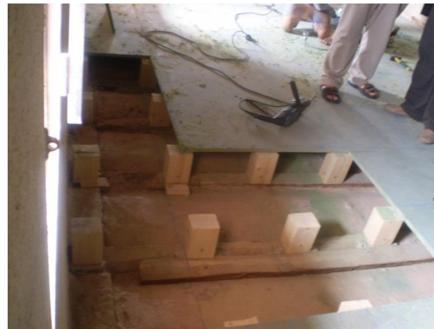
Estado actual sala AD, colocación tacos de madera y tablero hidrófugo superior, con los tirafondos de conexión
