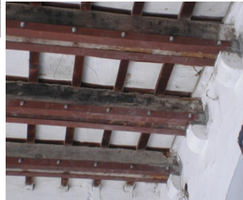
Reparación viguetas de madera
