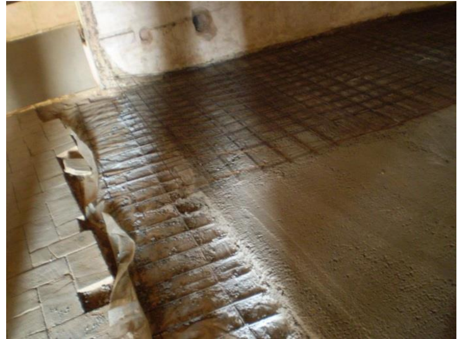
Hormigonado de la capa de compresión (véase la zona de solape)
